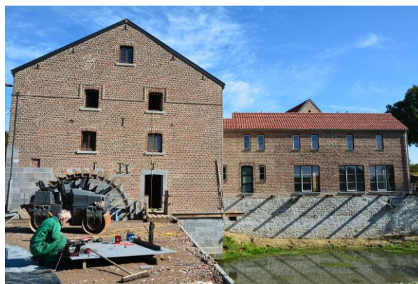
Fig. 38 - Avennes, le moulin en restauration
