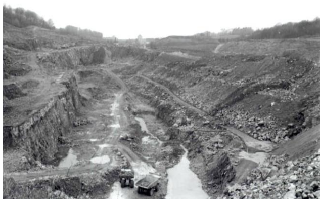
Fig.121 – Moha, dumpers v. 1960 dans PPT Carmeuse
