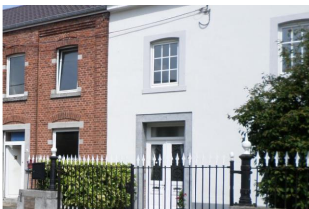
Fig. 75 - Photo maison avec crépi néo-classique - VERSTRAETEN J., 2019
