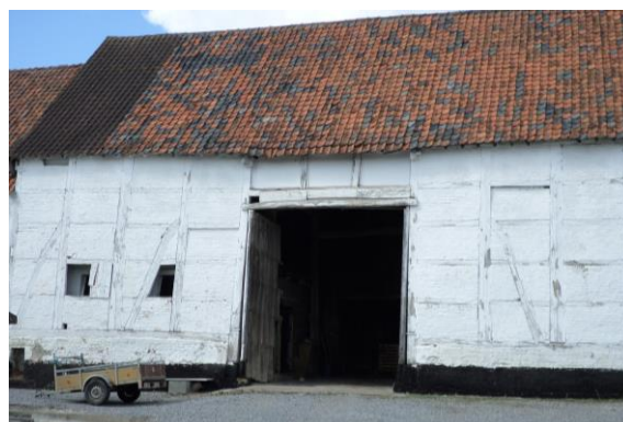
Fig. 57 - Waret-l'Evêque, grange en colombage - VERSTRAETEN J., 2019
